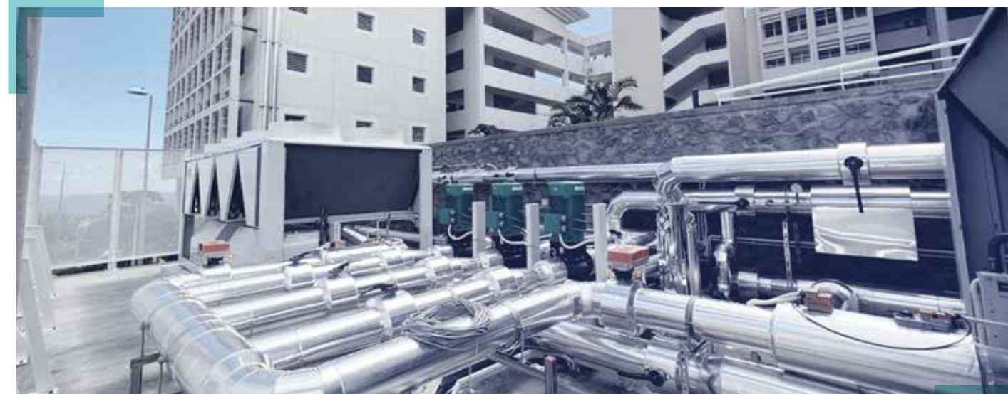
Sur le campus du Moufia, d'important travaux de rénovation énergétique et GER ont été menés
